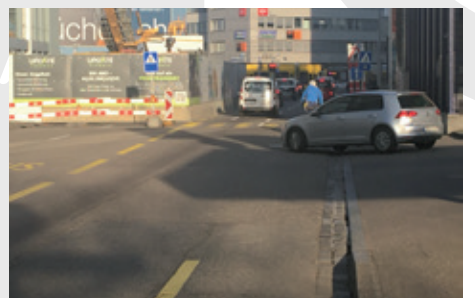
Ungenügende Baustellenführung im Leimgrubenweg
