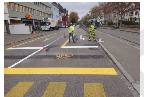
Aufstellbereiche erleichtern das Abbiegen und machen Velofahrende besser sichtbar
