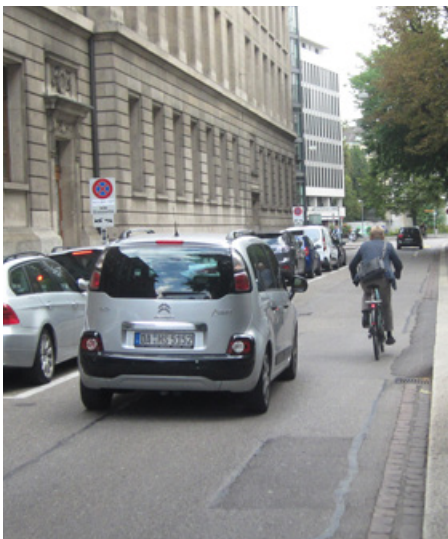
Die Autoparkplätze im Brunngässlein verhindern eine sichere Veloführung.
