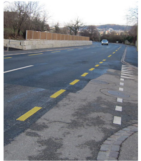
Auch die Querung auf Höhe Kummelenstrasse ist dank der Umgestaltung übersichtlicher geworden.
