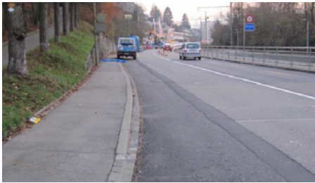
Baustellen-Pfusch in Binningen
